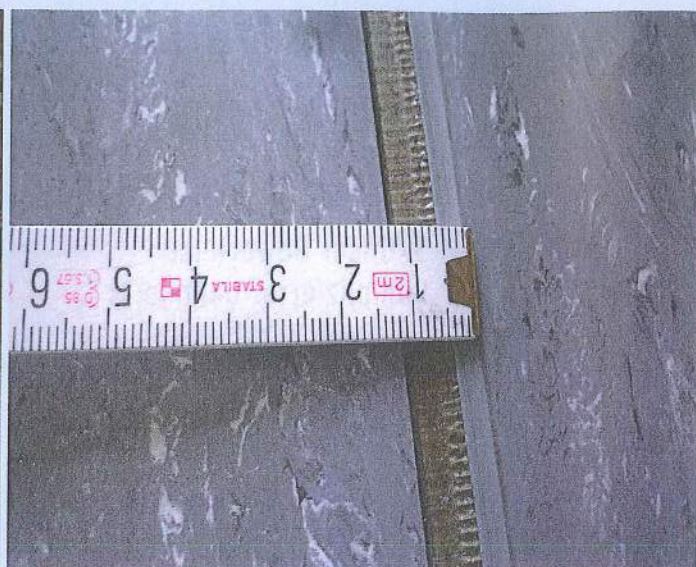
Erheblicher Schrumpf, direkt neben einer Schweißnaht, auch im Klebstoffbild erkennbar.
