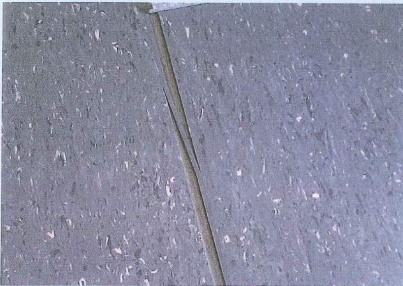
Hier wurde die Fugenbildung durch Reinigungsmittel hervorgerufen.
