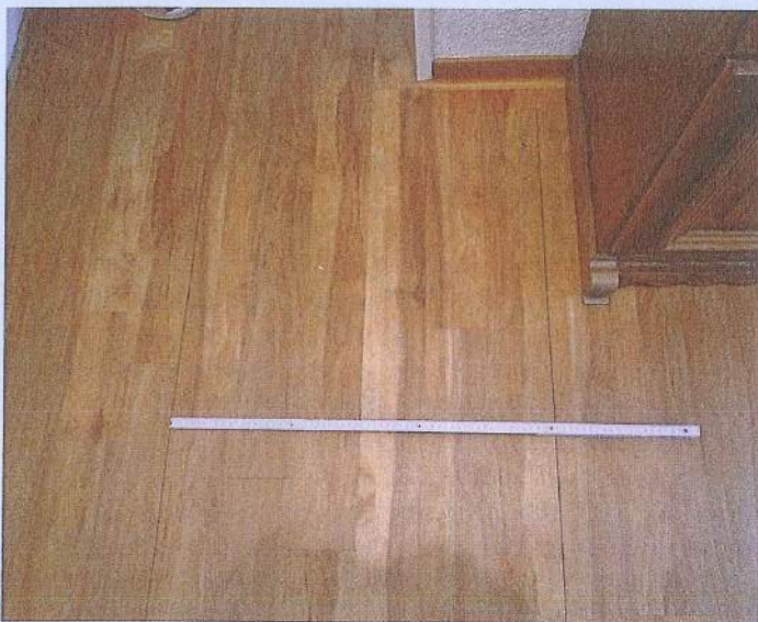
Fugenbilder bei einem Designbelag: „Abrissfugen haben wir auch“, sagt Wollenberg in Anlehnung an gleichartige Bilder bei Parkettböden.
