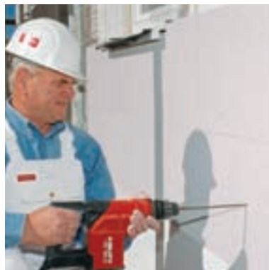
Zusätzliche Befestigung der Ytong Multipor Dämmplatten mit geeigneten Dübeln.
