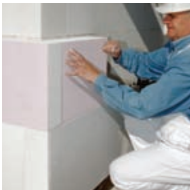
Dämmplatte an die Wandoberfläche andrücken und einschwimmen.
