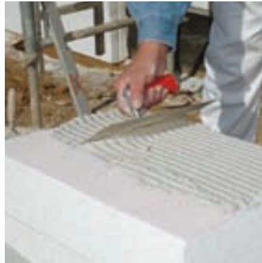
Mit Zahntraufel (10er- oder 12er-Zahnung) vollflächig aufgetragen, ergibt mindestens 70 % Klebflächenanteil.
