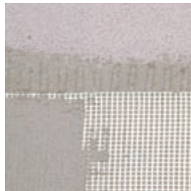
Armierungsgewebe in den Ytong Multipor Leichtmörtel einarbeiten.
