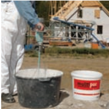
Leichtmörtel anrühren. 20 kg ergeben in 8 l Wasser (Markierung am Messeimer) ca. 30 l Klebemörtel.
